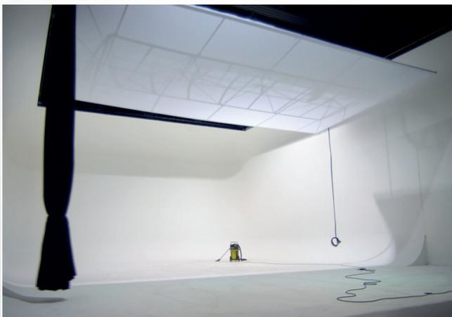
Das Deckensegel dient perfekt für eine indirekte Beleuchtung und ist mit seinen 10x6 Metern in alle Richtungen über jeden Winkel mit einer Fernsteuerung frei beweglich. Der an der Decke angebrachte Portalkran trägt eine Last von 10 Tonnen, um zum Beispiel Fahrzeuge oder andere Lasten im Aufbau abzusetzen.
